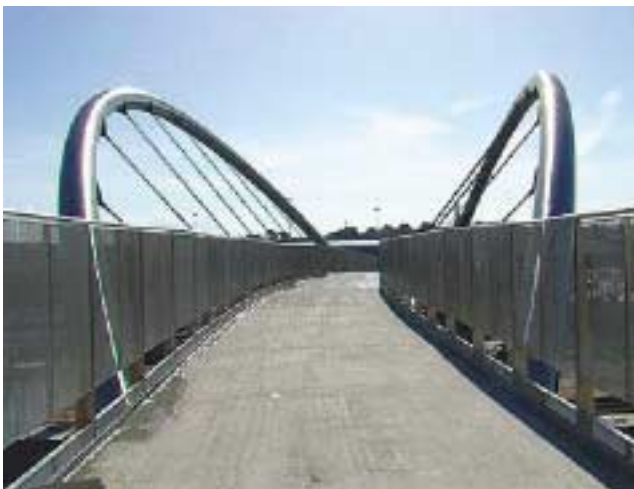
Рис. 15. Мост из нержавеющей стали в Великобритании
